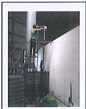
固化及人工喷粉线 烘烤炉废气排放口
